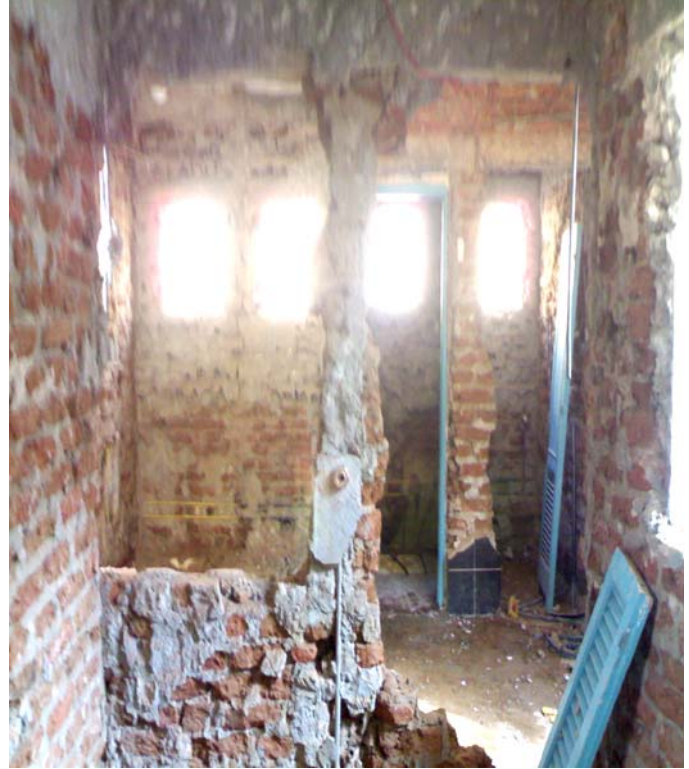
أعمال تجديد دورات المياه
